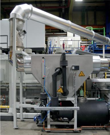
**Bild 3:** Wärmetauscher und Abgasführung
